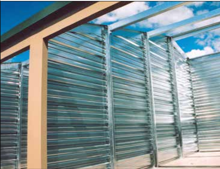
11. Vista interior de la pared de separación completa.
