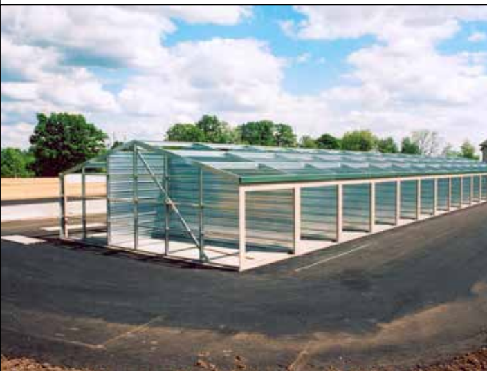
18. Esta pared del perímetro no tiene puertas. Toda la pared se cubrirá con un panel en forma de A.
