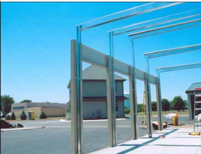
12. Instale un clóset del extremo para todas las unidades de 5' de ancho siguiendo los pasos del manual de montaje de techo de inclinación variable. Las correas de las paredes del perímetro se unen a las columnas de las paredes del perímetro.
