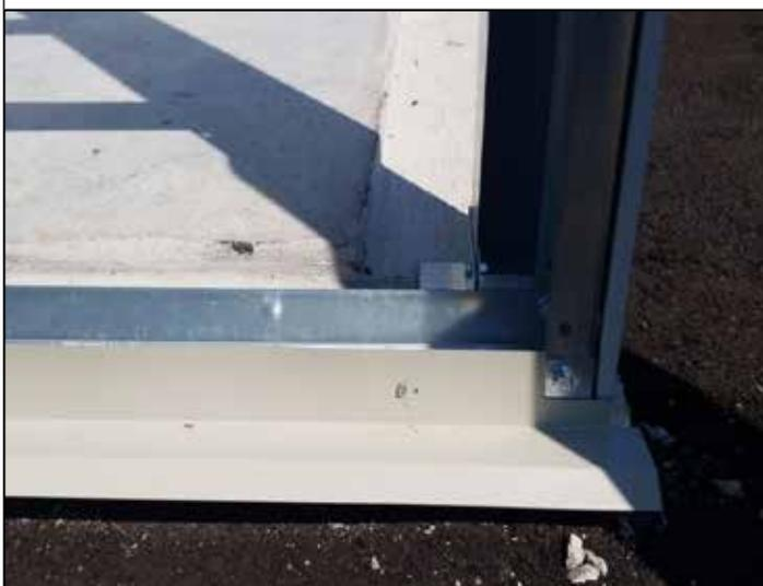
108. Atornille con tornillos Tek cada extremo de la moldura del umbral para fijarla. La moldura del umbral se asegura con los sujetadores para el panel en forma de A cuando el panel en forma de A se instala más adelante.
