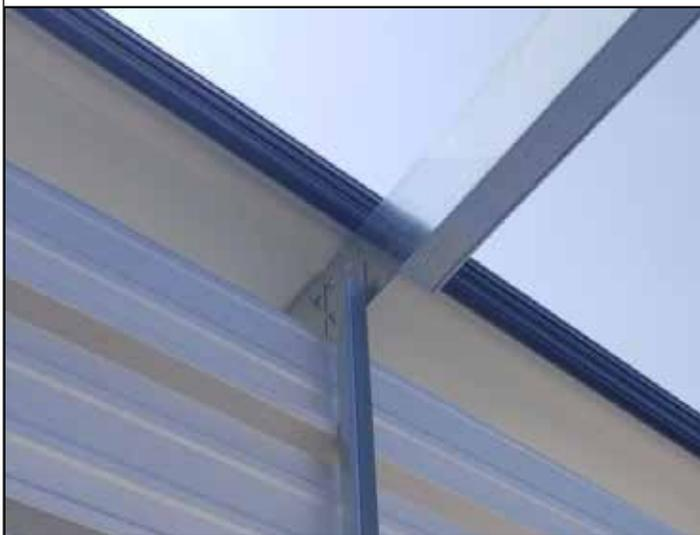
101. Configure a plomada el canal contra la correa y atorníllelo a cada nervio del panel de separación.
