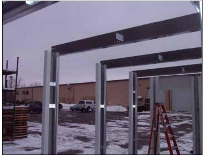
62. Si su edificio tiene puertas que no funcionan, instale jambas de esquina en la esquina del edificio.
