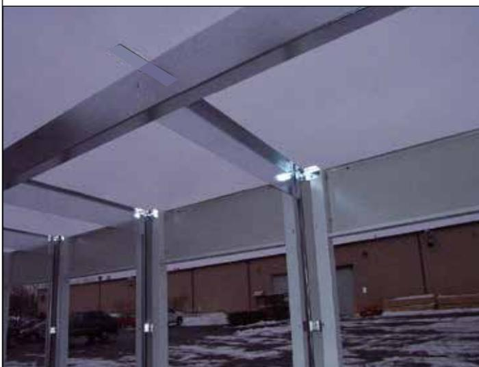
90. Instale todos los ángulos de incidencia (si los compró) entre las correas. El ángulo de incidencia llena el espacio en la parte superior de la pared de separación. Los ángulos de incidencia solo son necesarios cuando se planea colocar un panel de separación. Deben instalarse todos los ángulos de incidencia antes de instalar el techo.
