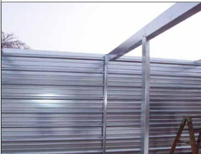
102. Instale una columna telescópica secundaria a la correa y fjela al piso. La columna telescópica secundaria se utilizará en todas las ubicaciones donde se necesiten separaciones.
