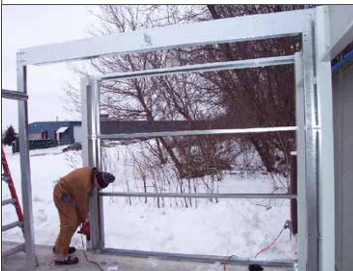
84. Instale las viguetas y el riel base. Se puede instalar una jamba inicial en la columna de la esquina.
