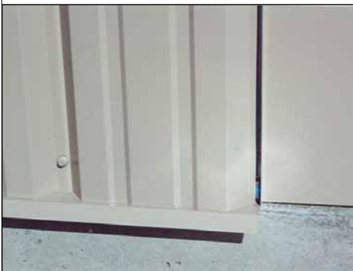
114. Este es un ejemplo de un panel en forma de A utilizado como pared que termina en la ubicación de una jamba inicial en una pared lateral. Esto deberá acabarse con una moldura.
