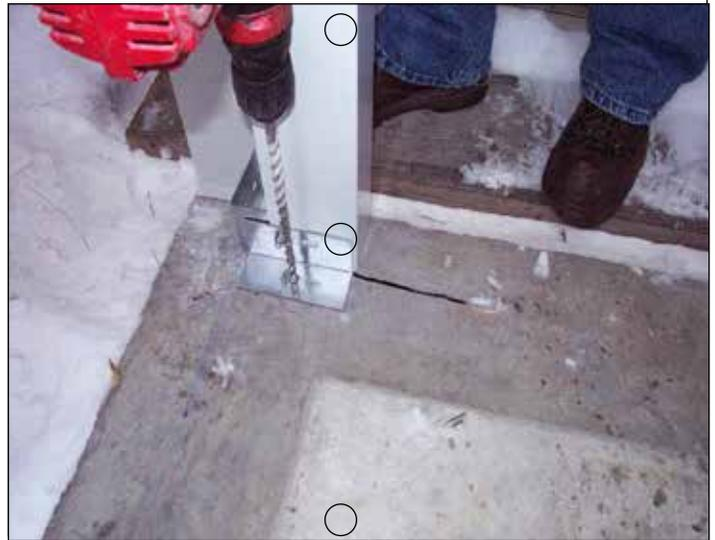
80. Instale una columna de esquina en la jamba inicial y fije la columna al riel base con dos pernos. El riel base se ancla a la losa con tornillos a través de los orificios que ya vienen perforados. Consulte la portada de los planos.
