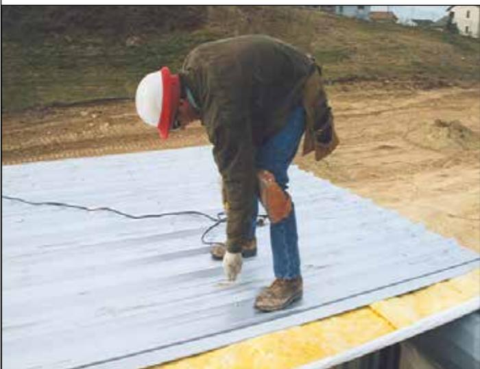
161. Atornille el techo en cada correa en incrementos de 1'. Use una línea de tiza para asegurarse de no omitir una correa.
