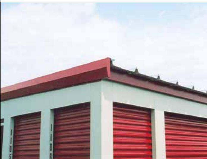
173. Coloque la moldura de cenefa encima de la moldura del adaptador y atorníllela usando tornillos de puntada cada 12" a lo largo de toda la longitud del panel. El extremo de la moldura de cenefa debe alinearse al borde de la lámina del techo.
