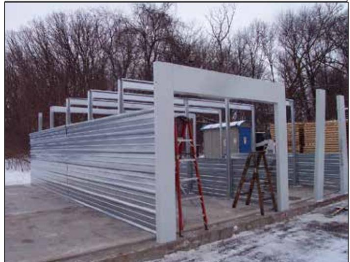
39. Instale el canal del tramo del alero (serie de n.º/p 5900) en el dintel. Los canales de los tramos del alero se superponen en el centro de los dinteles tal como se detalla en los planos; consulte la portada para obtener más información sobre dónde puede encontrar detalles de los dinteles.
