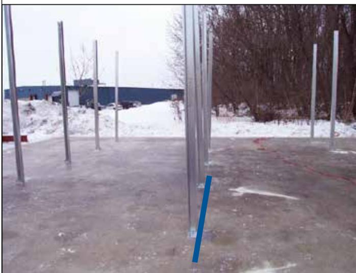
11. Las columnas de la bahía inicial se instalan en el lateral izquierdo del borde de las columnas.
