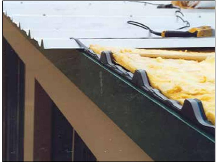
163. Esta es una imagen de una lámina del techo acabada para un edificio sin canaletas. Los edificios que tienen canaletas tendrán un voladizo más corto que este. Los voladizos correctos para edificios con y sin canaletas son 1 1/2" y 4"-6", respectivamente.
