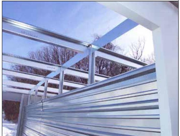
92. Mida la distancia hasta la correa y **haga una muesca de 1/4" con una cizalla, cizalladora o contorneadora.** Levante la separación hasta donde corresponde y fíjela.
