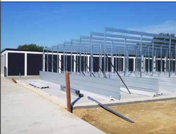
18. Para configurar a plomada la fila de columnas en el otro plano, instale el primer panel de separación. Consulte la hoja F del diagrama de montaje para determinar cuál panel de separación debe utilizar. Si su edificio tiene más de 20' de ancho, deberá utilizar dos piezas de separación a lo largo del ancho.
