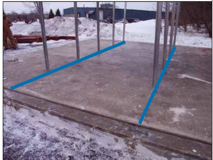
9. Cuando las columnas se fijan a las placas base, se ven así. Tenga en cuenta que la placa base de la jamba de puerta está a la izquierda del borde estructural. La placa base de la jamba de puerta no se instalará hasta más adelante (esta imagen se proporciona solamente para fines de referencia).
