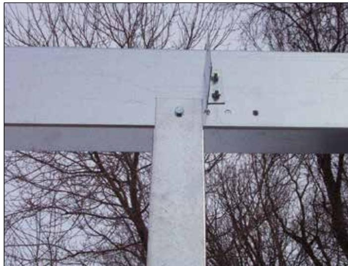
104. Doble en campo la base de la columna sobre los cimientos y alinee al borde estructural. Luego, configure a plomada y ancle usando los tornillos provistos. Coloque dos tornillos en el lateral de la columna telescópica para inmovilizarla.
