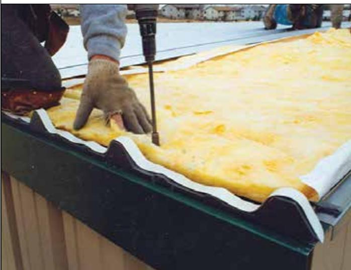
154. Fije el aislamiento con tornillos Tek #760600 y arandelas grandes #766000. Asegúrese de estirar el aislamiento para que quede ajustado y evitar que tenga holgura. De esta forma, tendrá un aspecto agradable al verlo desde el interior del edificio.
