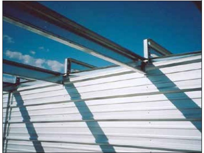
196. Los paneles del techo deben alinearse con el escalón como se muestra. Luego se instalan las piezas de la moldura.
