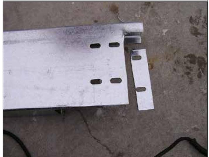
75. Instale la correa entre las columnas. Utilice un nivel para instalar las correas en los orificios de los pernos correspondientes. Asegúrese de que el alma de la correa quede sobre el borde estructural. \*Si se construye sobre un declive de 1 grado, la correa estará perpendicular al piso y es posible que no esté nivelada.
