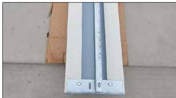
54. La columna de la pared del perímetro debe estar orientada sobre el borde estructural. Consulte la portada del plano para ver la orientación de las columnas.
