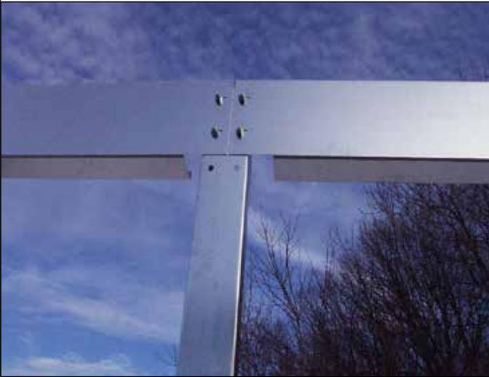
29. Una vez que la bahía inicial se haya construido, reforzado y conectado bien, puede proceder a construir todas las bahías típicas. Para las bahías típicas, va a utilizar correas de bahía típicas (serie de n.º/p 6000). En este punto, los requisitos de refuerzos deben ser mínimos. Siga reforzando y configurando a plomada según corresponda.
