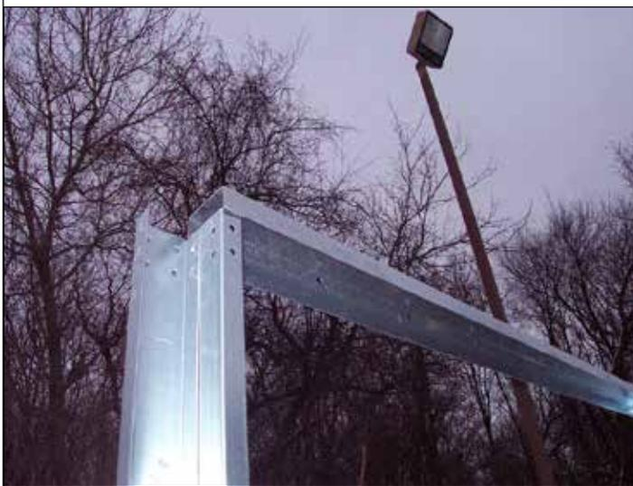
83. Fije el riel superior en la columna. Las columnas tienen dos conjuntos de orificios. El conjunto de orificios inferior se utiliza cuando no hay una muesca en la base. Los orificios superiores se utilizan cuando no hay una muesca en la base.
