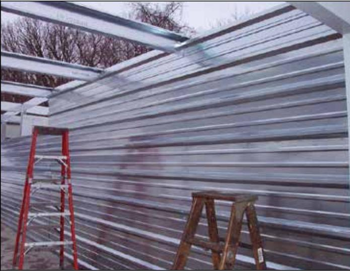
95. Instale la separación en la parte inferior del techo. **No asegure al ángulo de incidencia.** La separación deberá cortarse en el campo si se extiende más allá del borde del techo. Consulte la hoja de Separaciones internas de los planos para obtener más detalles sobre las separaciones.
