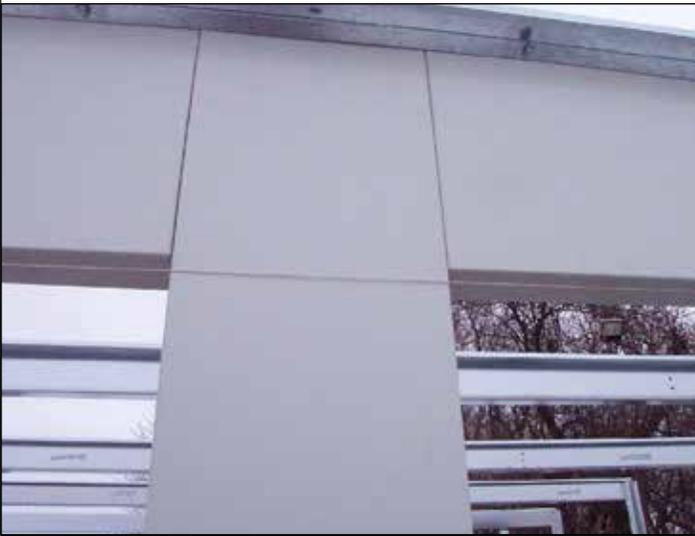
46. Configure la jamba a plomada siguiendo el hilo que ha unido a ambos extremos del edificio como guía. Fije con abrazaderas y sujete la separación a la columna de soporte.
