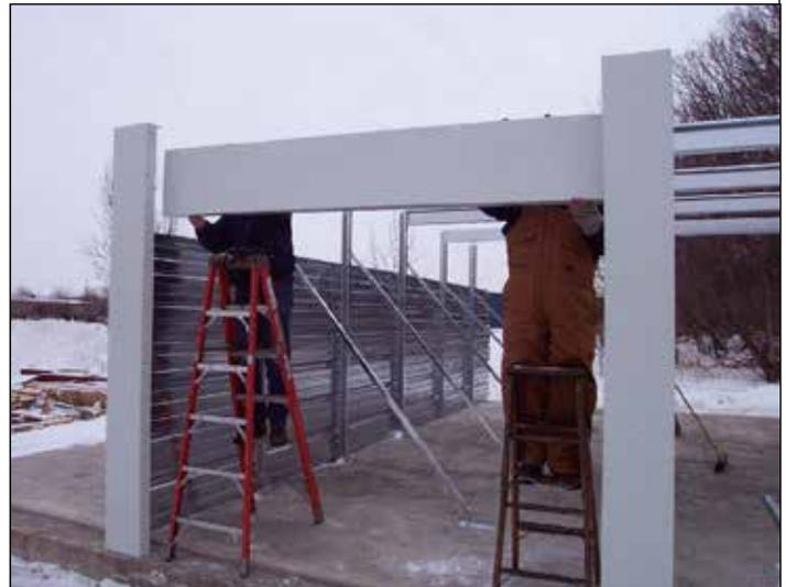
38. Una vez instalados, la jamba de puerta y el dintel se ven así. Solamente la primera jamba está fijada a la separación en este momento. La otra jamba de puerta no se fijará a la separación hasta que se instale un hilo más adelante. Si necesita sostener la jamba, sujete temporalmente la separación a la jamba con una abrazadera hasta que sea el momento de aplomar y enderezar la pared.
