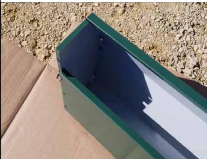
182. Perfore la tapa del extremo de la canaleta hasta el final de la primera canaleta y aplique remaches pop.
