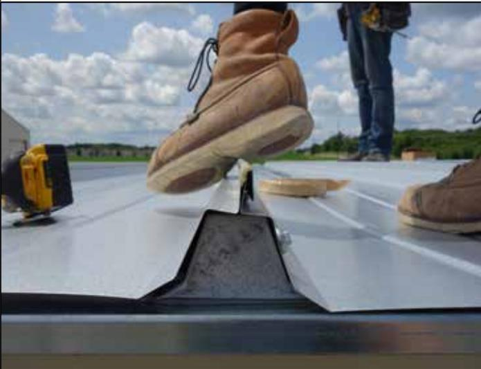
137. Encaje a presión el siguiente panel sobre el panel ya colocado presionando firmemente la unión con el pie. Comience en un extremo y siga hacia el otro extremo del panel. Si tiene algún problema, comuníquese con el Servicio al cliente.
