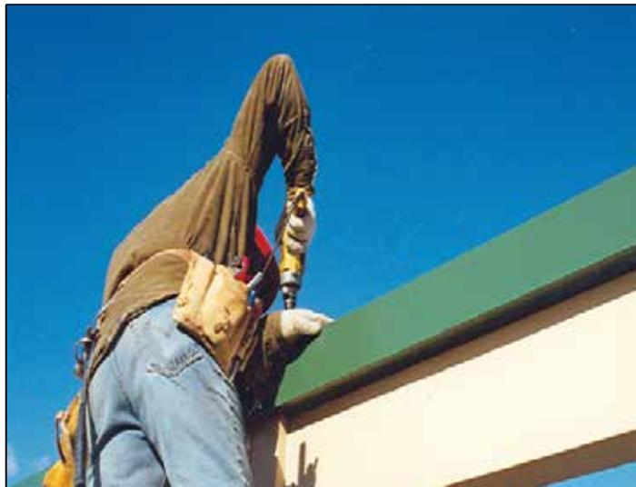
122. Superponga el tirante del alero del dintel sobre el tirante del alero instalado.
