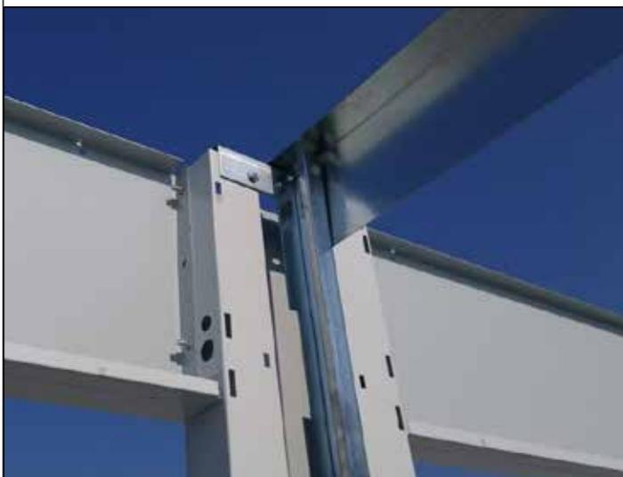
88. Esta es una imagen del ángulo de incidencia instalado y al que se le hizo una muesca en el campo en una jamba de la pared lateral.
