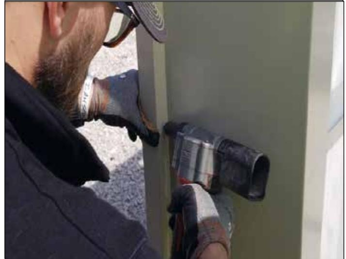
117. Instale la moldura de la pared lateral en la parte superior, central e inferior con remaches pop. Trabaje en una sola dirección, desde abajo hacia arriba, y en una superficie a la vez. De esta forma, los bordes se mantendrán planos.
