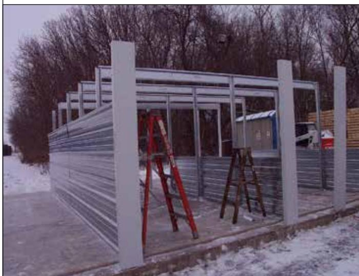
36. Instale las jambas de puerta restantes en las paredes laterales del edificio en este momento. No las fije a la separación. No se fijarán a la separación hasta que se instalen los dinteles y se configure un hilo (véase la imagen 45).
