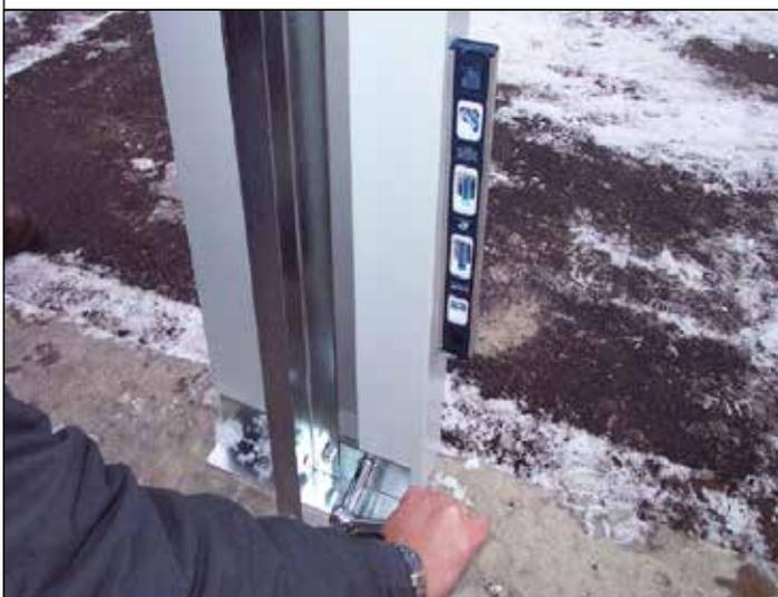
66. Una vez que haya instalado todos los dinteles, configure la jamba de puerta a plomada y ajuste la placa base.
