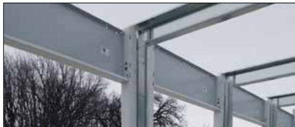
53. Monte de forma que el alma de la columna quede orientada sobre el borde estructural. Las alas deben estar orientadas hacia la pared lateral al igual que las columnas interiores. De esta forma, las correas estarán alineadas cuando se instalen.
