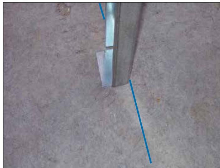
105. Instale la primera placa de separación insertando el panel en el canal y luego fijando el lado opuesto a la columna. Siempre debe haber un canal vertical y una columna a los que se deben fijar los extremos del panel.
