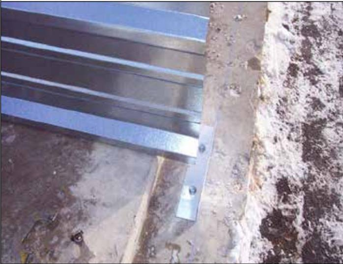
17. La ubicación de la separación se verá así cuando la placa base de la jamba de puerta doble está instalada. Verifique el borde del panel para asegurarse de que esté instalado a plomada.
