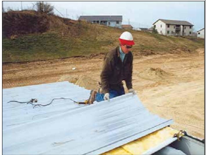
157. El panel del techo se puede doblar fácilmente sobre el caballete. El techo del panel en R se puede doblar sobre el punto más alto para lograr una inclinación del techo que sea de hasta 1/2”-12”.
