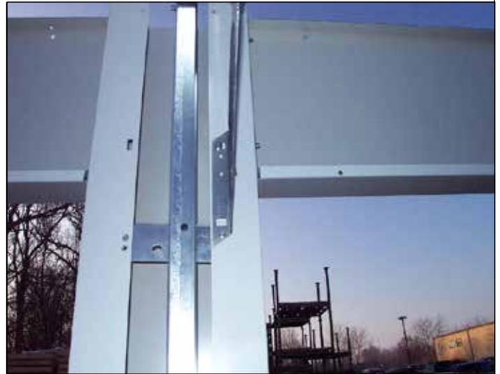
68. Esta es una vista interior del clóset de la pared del perímetro ensamblado. Observe que las placas base instaladas están justo debajo de los dinteles. Los clips de las correas se usan para unir los ángulos que se necesitaban para este edificio. Consulte la portada de los planos para ver si necesita alguna unión de refuerzo.
