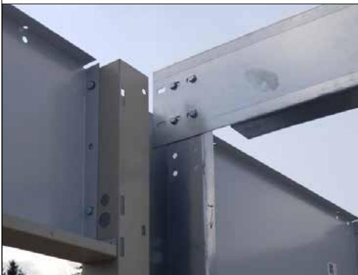
59. Instale la correa en la columna de la pared del perímetro usando un conjunto de orificios en la columna. Verifique que todas las correas estén niveladas.
