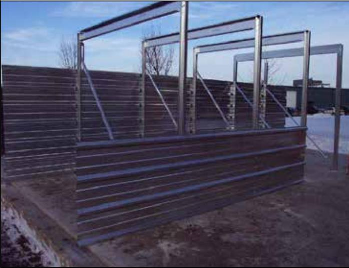
28. En todas las filas de columnas subsiguientes se instalará una fila de paneles de separación. Instale el panel de separación en el lado del borde estructural de la columna. La primera bahía de esta imagen es una bahía inicial. Por lo tanto, el panel de separación se encuentra en el lado opuesto (borde estructural) de la columna en comparación con la otra fila de columnas.
