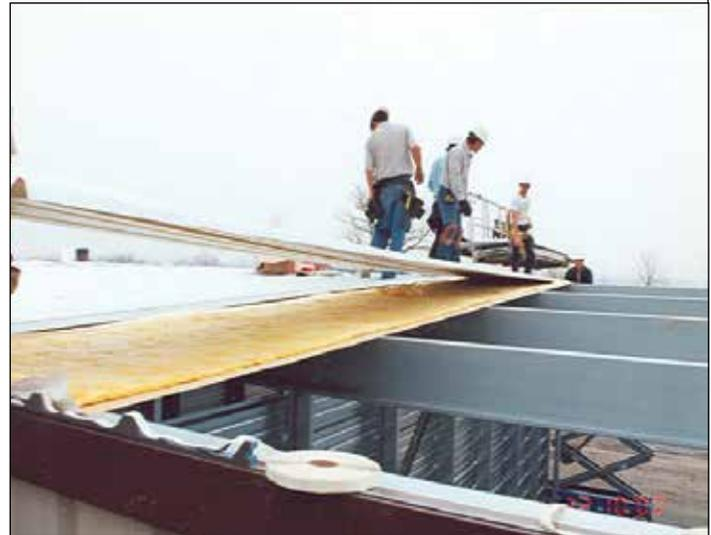
158. Coloque las láminas del techo en el techo, ya sea a mano o utilizando un camión Lull. Los paquetes de láminas largas son susceptibles de ceder y doblarse. Asegúrese de tomar todas las precauciones necesarias para garantizar que ninguno de los paneles ceda. Antes de elevar la tarima de láminas del techo, asegúrese de orientar los tramos que tienen correas en la dirección correcta (véanse las notas 152 y 154). Retire el encofrado antes de levantar los paneles.
