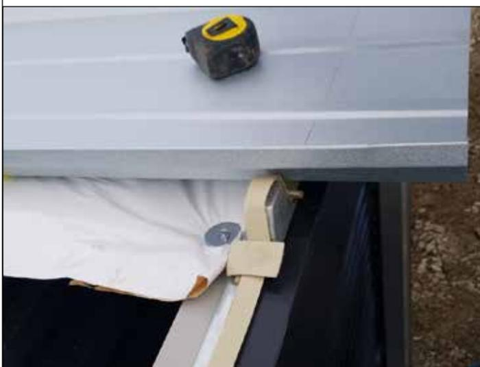
132. Para empezar a instalar el techo, instale un rollo de aislamiento de 6' de ancho. Doble y fije el aislamiento al dintel usando arandelas grandes #766000 y tornillos Tek #760600. En este ejemplo, estamos instalando aislamiento con un espesor de 3/4". Si tiene un aislamiento de 3" o más, use un tornillo Tek de 1-1/4" #710969.
