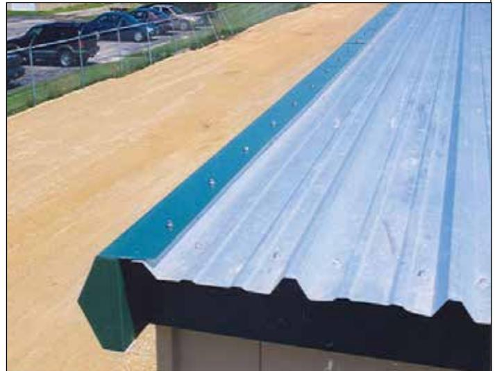
176. Alinee la moldura de cenefa al borde de la lámina del techo. El ala inferior de la moldura de cenefa se puede recortar hasta que quede al ras con la moldura de esquina. Fije la moldura de cenefa al panel en forma de A con tornillos Tek pintados que hagan juego con el color de la moldura de cenefa.
