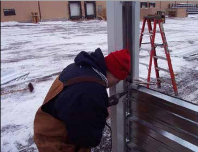
47. Sujete la placa de separación al panel de soporte. Utilice dos tornillos Tek entre cada nervio de la separación (2 por pie lineal). Consulte la página 15 o los detalles en la portada de sus planos.
