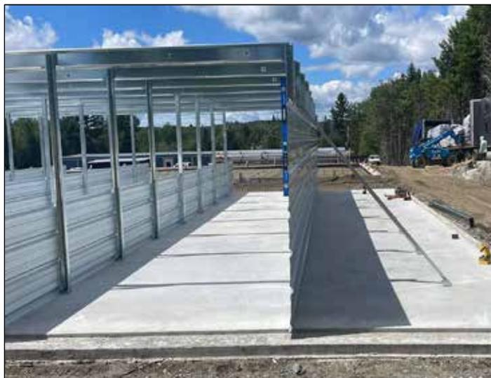
27. Fije la correa a la columna y atorníllela al conjunto de orificios superior. Los dos (2) orificios inferiores son para las correas más profundas que deben usarse en casos especiales. La correa tiene orificios alargados horizontales para permitir las modificaciones que sean necesarias para que la columna quede vertical.
