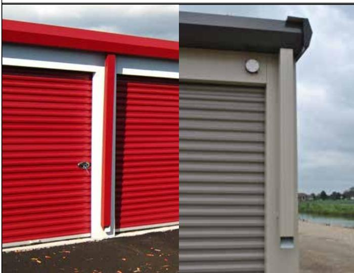
193. Generalmente, los tubos de bajada pluvial se instalan de forma que terminen justo encima del hormigón. Si el tubo de bajada pluvial debe ingresar a un drenaje subterráneo, requerirá tubos de bajada pluvial extendidos. En ubicaciones de climas fríos, una alternativa es acortar los tubos de bajada pluvial para que no interfieran con el trabajo de eliminación de nieve en su sitio.
