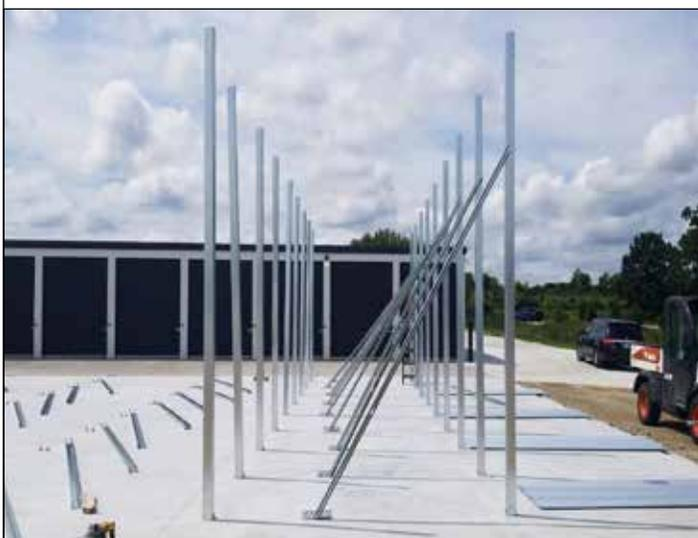
12. Asegúrese de que la primera pared (bahía inicial) esté a plomada y refuércela, usando los canales de separación para soportar temporalmente las columnas. Los refuerzos se quitarán y se volverán a utilizar más adelante una vez que las paredes estén estabilizadas.
