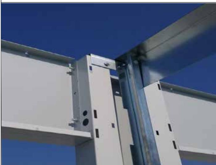
40. La jamba de puerta tiene una placa base preinstalada en la parte superior como se muestra en este diagrama. Los dinteles se atornillan a la jamba de puerta. Apriete los pernos del dintel cuando el lado exterior de los dinteles y las jambas estén al ras.
