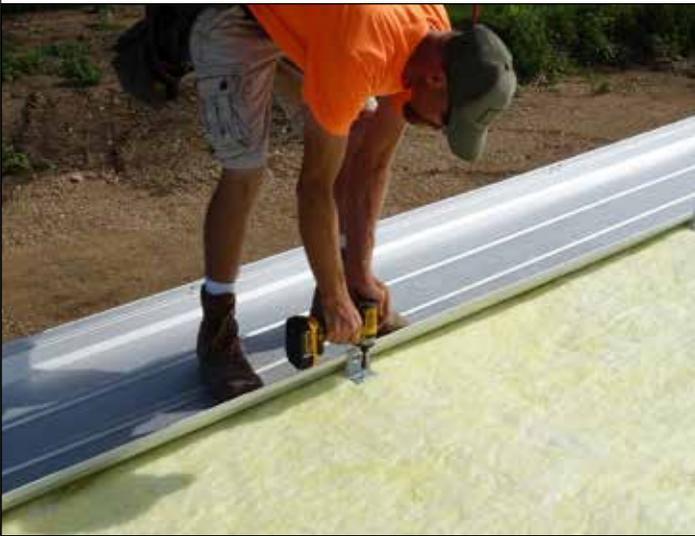
136. Instale los clips del techo con juntas verticales. Hay tres tipos de clips, cada uno para aislamiento de diferente grosor. El clip multiuso #710933 se puede usar con aislamiento de hasta 2". Consulte la página de detalles para obtener más información. Use el clip de 3-3/8" #710960 para aislamiento de 3" o 4". Los clips que se utilicen se atornillarán a la correa con dos tornillos #710969.
