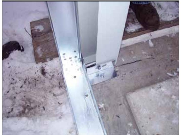
81. Instale las viguetas interiores en la columna y el clip.
