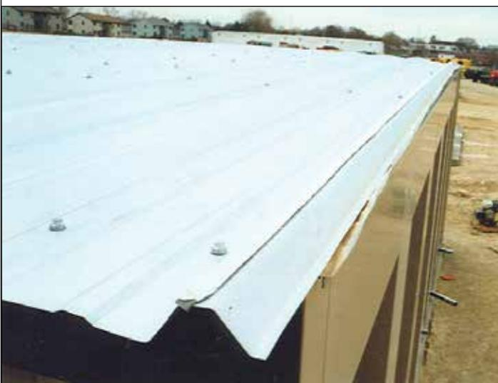
167. El último panel de la lámina del techo debe terminar en un nervio alto para sellar adecuadamente el extremo del techo. Debe colocarse una tira de masilla en cinta en el último nervio para sellar la moldura de cenefa.
