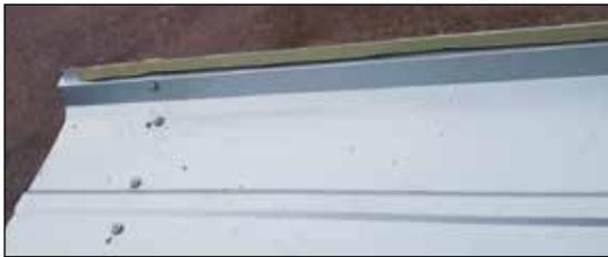
170. Instale la moldura del adaptador de cenefa sobre el borde del techo con juntas verticales. Atornille la moldura al ángulo de incidencia usando tornillos para techo Tek cada 6" a 9".
