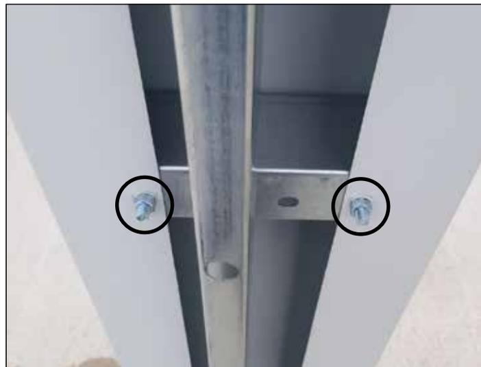
33. Atornille la placa base a la parte inferior de la jamba de puerta. Luego atornille el soporte a la placa base. El soporte es universal, por lo que se puede atornillar a ambos lados de los clips de sujeción para que el montaje acabado sea para la mano izquierda o derecha. El alma del soporte debe alinearse sobre el borde estructural para que el panel de separación pueda fijarse a ella. El ala del soporte debe estar en el mismo lado del borde estructural que el borde de la columna.
