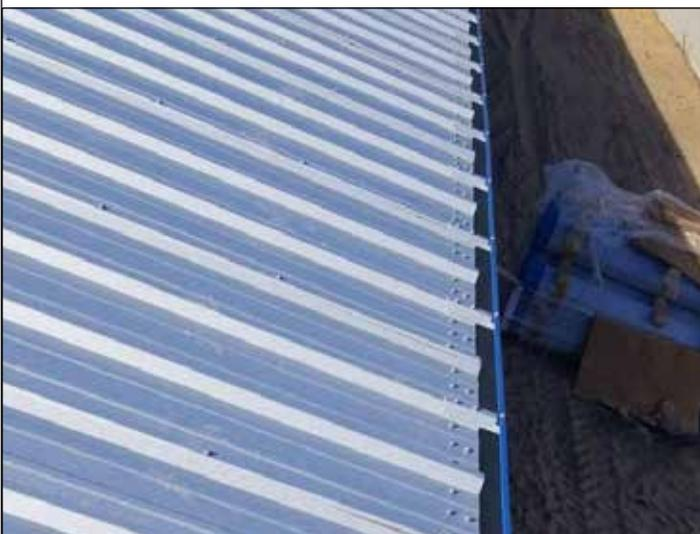
159. El patrón de tornillos Tek se ve así. Hay tres tornillos por pie en el alero. Hay un tornillo por pie en cada correa. Se necesita un tornillo de puntada en la superposición de los paneles cada 20" de forma centrada. Consulte los detalles de sujeción en la página 15.
