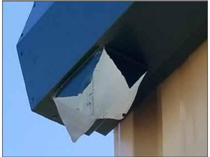
191. El tubo de bajada pluvial debe deslizarse por encima de las cuatro lengüetas de la canaleta. Perfore y remache con remaches pop tres lados de los tubos de bajada pluvial a través de las lengüetas.
