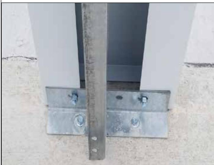
55. Encuentre el centro del clip de la base en el borde estructural y asegúrese de que el borde exterior de la jamba esté sobre el borde estructural exterior. Luego, proceda con la instalación usando los tornillos provistos.
