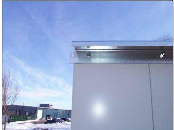
51. El canal del tramo del alero se puede cortar o doblar sobre el borde del edificio.
