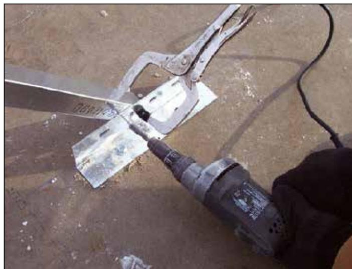
14. Primero, asegúrese de que la columna esté a plomada y luego use tornillos Tek para atornillar el refuerzo a la placa base. Una vez que esté reforzada, la fila de columnas debe estar a plomada y alineada en un plano a lo largo del ancho del edificio. Ahora, deberá configurarse esta fila de columnas a plomada en el otro plano.
