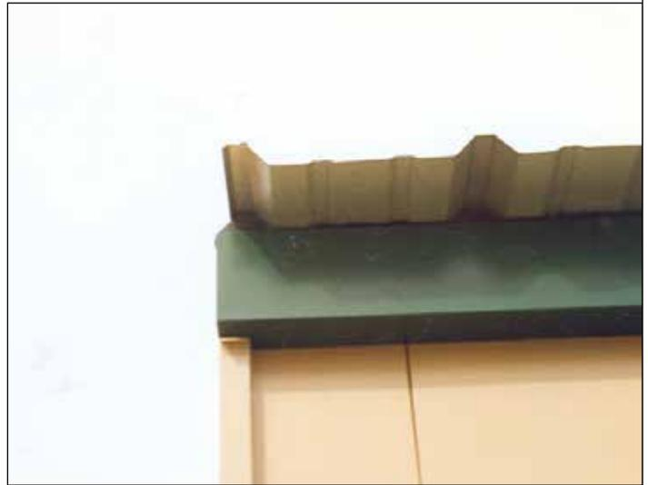
151. Fije las láminas del techo al alero con tornillos auto-roscantes EPDM.
