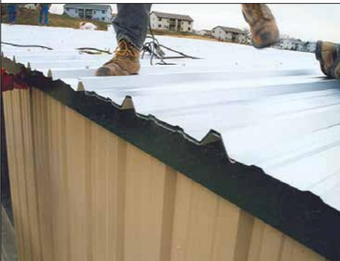
166. **No** cubra el panel como se muestra. Esto causará que el techo se oxide más rápido que si cortara el panel.
