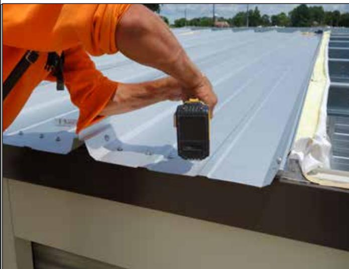
138. Instale los paneles siguiendo el patrón de tornillos que se detalla en la sección G de los planos de construcción.
