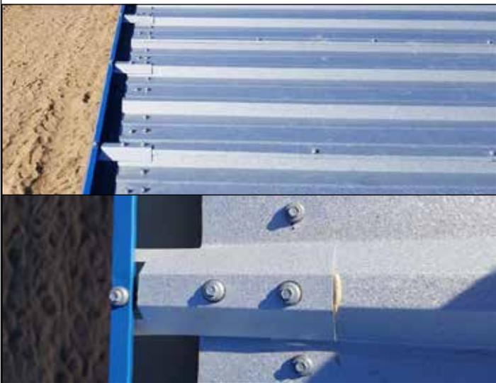
188. Para instalar canaletas en un techo de panel en R, debe pasar un hilo en la ubicación trasera de la tira de canaleta. De esta forma, puede asegurarse de que el borde frontal de la canaleta quede recto. Fije los portacanaletas para el techo de panel en R con dos tornillos de puntada de 7/8" de largo. Instale una tira de canaleta cada 2' a lo largo del edificio.
