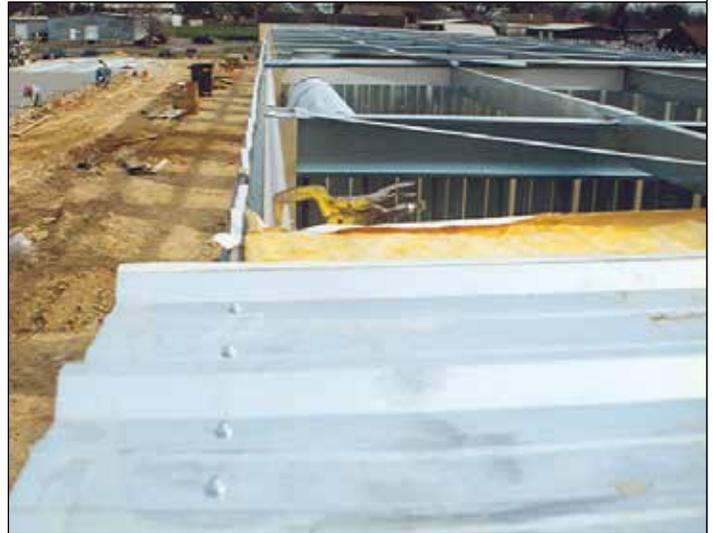
152. Los tornillos del alero se instalan perforando a través del cierre interior y la masilla en cinta de la moldura del alero, por fuera del envolverte del edificio.
