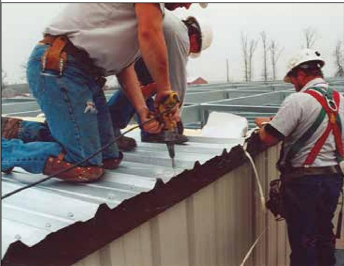
160. Siempre debe pararse sobre la parte plana del panel para asegurarse de no dañar ningún panel. No se pare sobre los nervios porque cederán.
