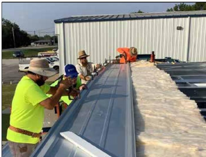
135. Deslice el panel del techo con juntas verticales sobre el ángulo de incidencia y atorníllelo en cada correa con tornillos Tek #760600 (ver los detalles del techo).
