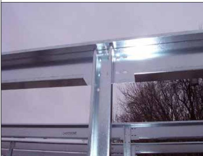
58. Fije la correa de la pared del perímetro a la columna interior. La correa de la pared del perímetro tiene tres conjuntos de orificios. El primer conjunto de orificios es para fijar a la columna interior (véase la imagen 59).
