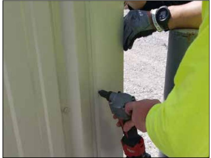
116. Asimismo, debe perforar y colocar remaches pop para fijar la moldura de la pared lateral hasta el reborde de la jamba inicial en la parte superior, inferior y en la ubicación de la vigueta.
