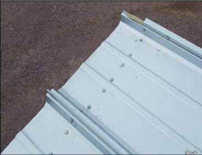
171. La moldura del adaptador se encuentra en el borde estructural de las paredes del perímetro. No extienda los extremos de esta parte más allá del borde estructural de la pared lateral. Al instalarse, no queda al ras de los extremos ni sobresale de las láminas del techo. Esto permitirá que las tapas de los extremos de la moldura de cenefa se ajusten bien sin requerir un corte en el campo o requiriendo uno mínimo.
