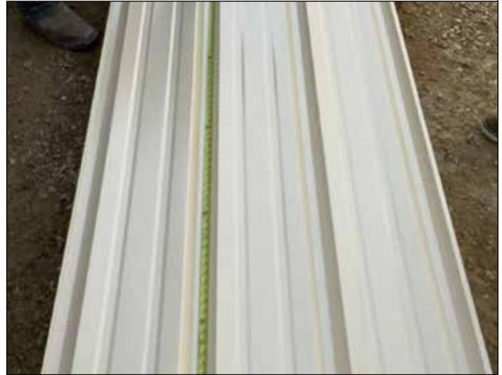
111. Coloque el primer panel de la pared cerca del borde del edificio. Si los nervios menores se mueven de 2" a 3" fuera del borde estructural, podrá asegurarse de que los tornillos que sujetan el panel a la estructura de la pared no golpeen la cabeza de un perno cerca de las ubicaciones de las columnas.
