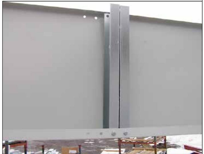
74. La correa de la pared del perímetro debe tener una muesca alrededor del ala del dintel. **No se debe aplicar una muesca sobre el dintel.**
