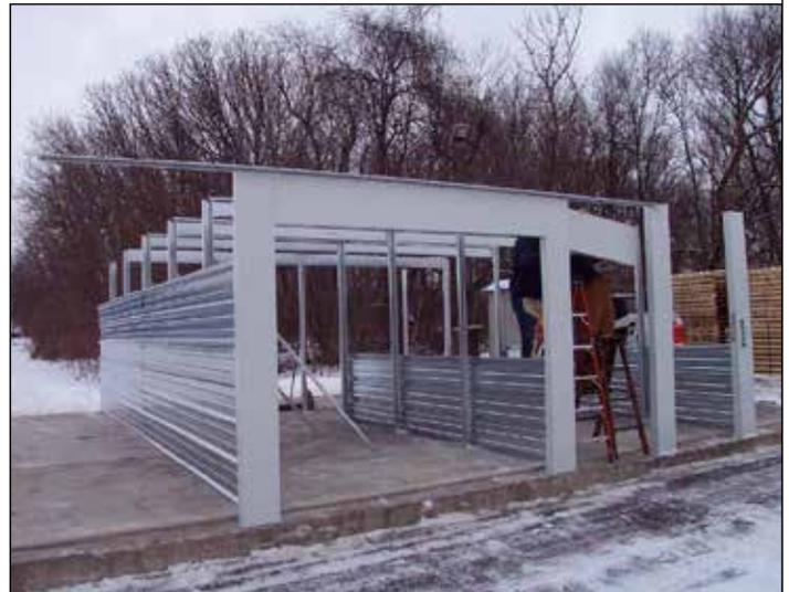
44. Siga instalando los dinteles, los ensamblajes de las jambas y los canales del tramo del alero a lo largo de la pared lateral del edificio. En este caso, los canales del tramo se superpondrán en la jamba entre los dos (2) marcos de las puertas de 4'. Use dos tornillos Tek para fijar los canales a los dinteles, en lugar de fijarlos a la jamba de puerta, **de modo que sea más fácil desmontar la jamba de puerta si llegara a dañarse.**
