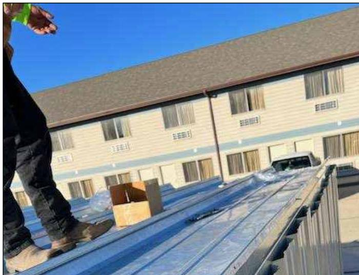
134. Consulte la portada de los planos para determinar el patrón y la secuencia de tornillos correctos para fijar el techo con juntas verticales. Use un hilo en el borde del techo para mantener la alineación correcta de todos los paneles.
