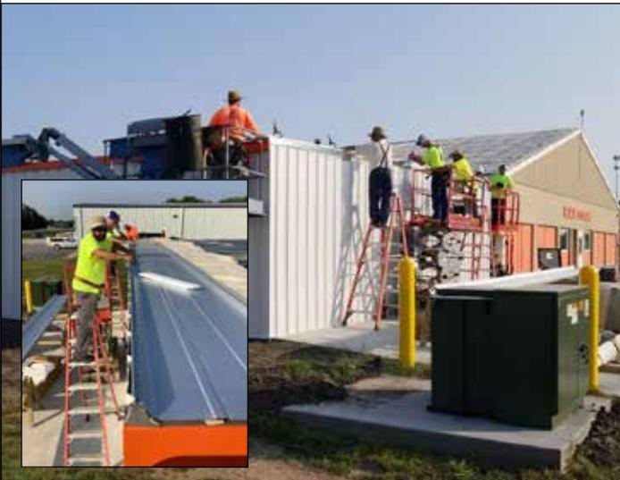
148. Levante la primera lámina del techo sobre el techo. Céntrela en el edificio para asegurarse de que quede un voladizo uniforme (véase la imagen 154).
