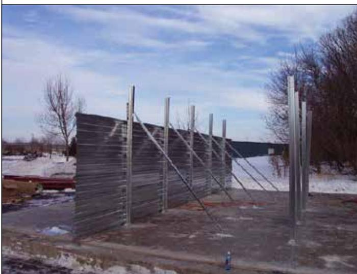
24. No ponga tornillos en la parte superior de 1' del panel de separación. Es posible que el panel superior traslape el panel de abajo. Tal vez necesite cortar el panel superior en el campo para que coincida con la inclinación del techo. Consulte la portada de los planos para encontrar el detalle del plano de montaje en los paneles de separación.
