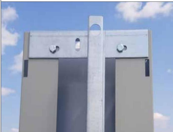
41. La placa base puede estar de cara hacia la unidad (como se muestra en la imagen) o hacia la pared exterior. Si se instala como se indica en el diagrama 12, deberá hacer menos cortes en el campo para que se ajuste al ángulo de incidencia.
