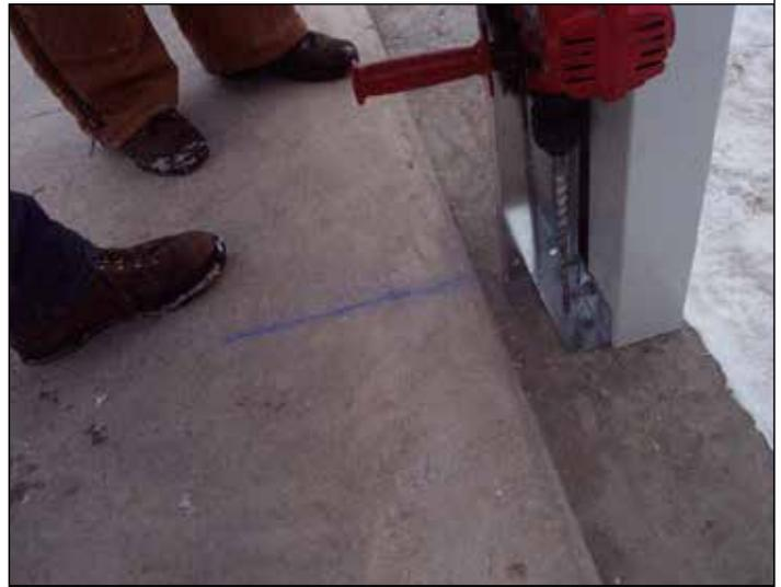
56. Instale las correas de la pared del perímetro. Las correas de la pared del perímetro se indican en las hojas 'C' del plano de la estructuración del techo.
