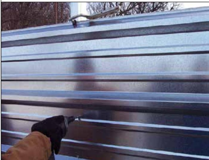
23. Termine de instalar la segunda fila. Una vez instalada, la pared deberá reforzarse en ambos planos. Ahora tiene una pared estable y a plomada desde la que puede empezar a construir.
