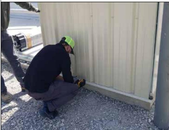
112. Siga fijando las placas usando los orificios piloto que se perforaron con anticipación.
