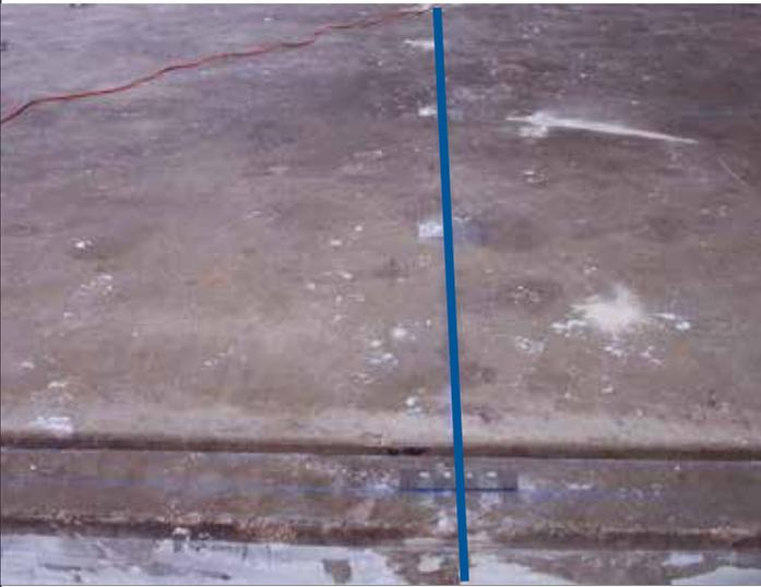
4. Instale las placas base de la columna interior en el mismo lado del borde estructural. Centre la placa base de la jamba de puerta en el borde estructural como se indica. La placa base de la jamba de puerta no se instalará hasta después de que se construya la primera pared. En esta imagen se indica su ubicación.
