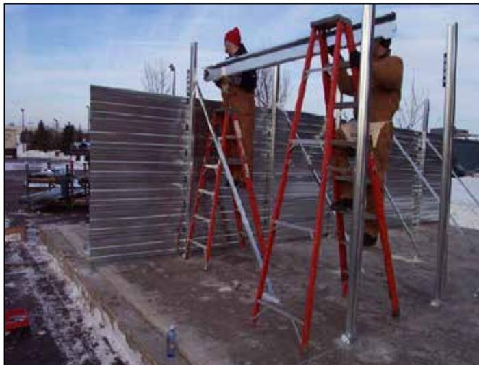
26. Instale las correas en la bahía inicial como se indica. La parte abierta de la correa en C siempre debe estar orientada hacia el exterior del edificio. La correa siempre debe instalarse sobre el lateral plano de la columna. Consulte la página 16 para conocer la distribución de las columnas.
