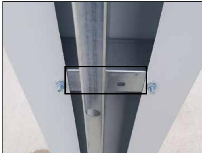
32. Atornille los dos clips de la jamba a la jamba y al soporte de la jamba. El alma del soporte de la jamba debe quedar sobre el borde central del ensamblaje de la jamba. Los soportes deben instalarse de forma que creen montajes de jambas para uso con la mano izquierda o derecha. Necesitará una configuración para la unidad cerca de la pared lateral cercana y otra para la otra pared lateral.
