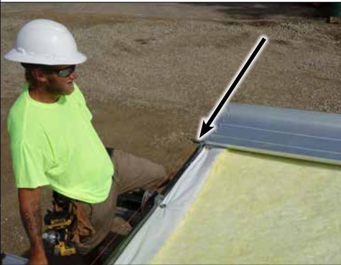
147. Comience con un rollo de material de aislamiento de 6' de ancho. La lámina del techo es de 3' de ancho, por lo que 3' del aislamiento quedará traslapado. Esto hace que sea más fácil grapar el siguiente rollo de aislamiento al primer trozo de aislamiento. Extienda el aislamiento y fíjelo a ambos extremos en el alero con un tornillo Tek #760600 y una arandela grande #766000 en el dintel, ala o riel superior.
