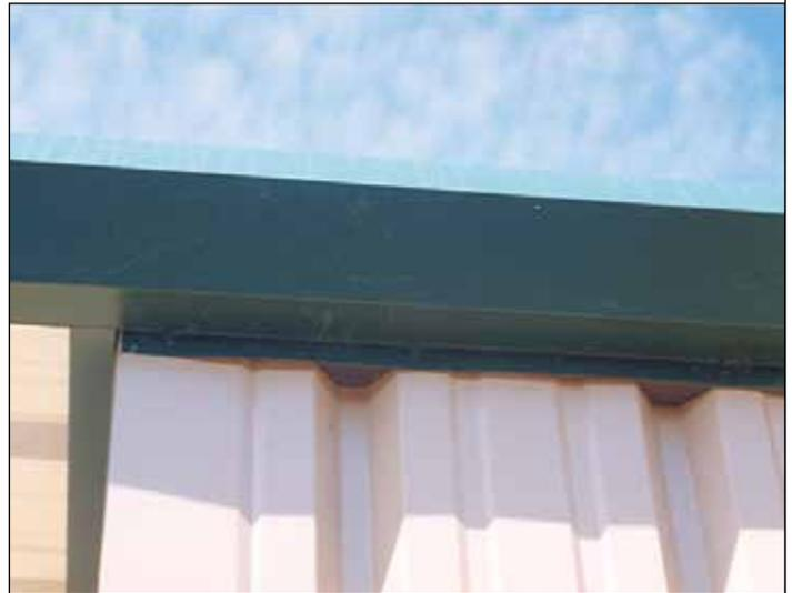
175. En un techo con paneles en R, el ala superior de la moldura de cenefa debe atornillarse al nervio alto del panel del techo con tornillos autorroscantes EPDM en color de 7/8". Consulte el detalle. Los tornillos deben atravesar la cinta de tres tiras.
