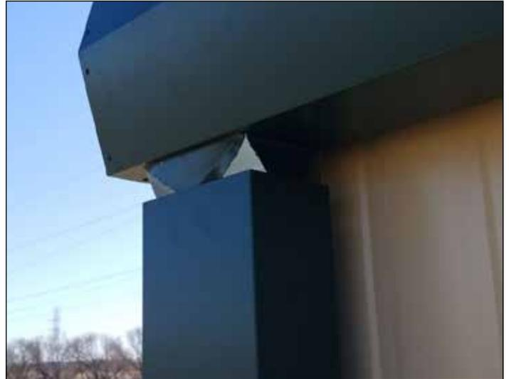
192. Atornille la tira de la bajada pluvial al costado del edificio con tornillos de puntada de 7/8" y arandelas EPDM. Posteriormente, perfore y remache la tira al tubo de bajada pluvial.
