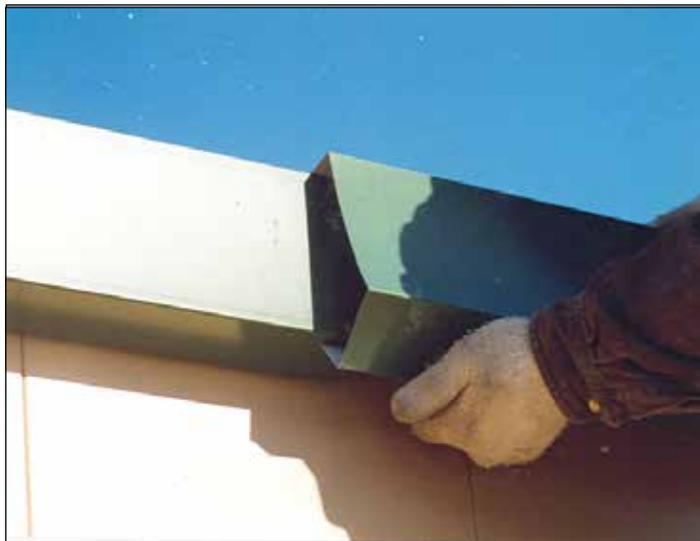
123. En esta imagen se muestra la unión de las dos piezas del tirante del alero. De ser necesario, se puede remachar la unión con remaches pop.
