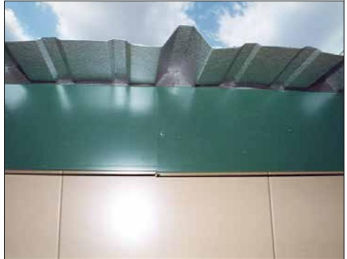
164. No todas las longitudes del edificio pueden dividirse en incrementos de 3'. En este caso, la última lámina del techo debe cortarse para que traslape correctamente el panel. Aplique masilla en cinta, como se muestra, para sellar el panel de techo superpuesto.
