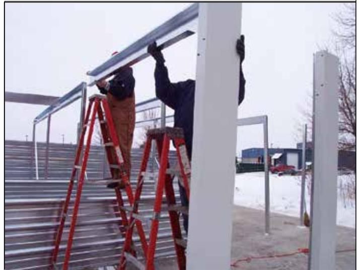
57. El extremo opuesto de la correa se fija con pernos a la columna (véase la imagen 58).
