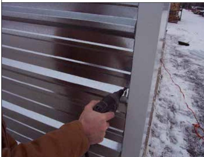
35. Coloque a plomada la primera y última jamba de puerta en los extremos opuestos del edificio. Luego, fije el panel de separación al soporte de la jamba para sujetar el ensamblaje de la jamba a plomada. Consulte las hojas "F" del plano.
