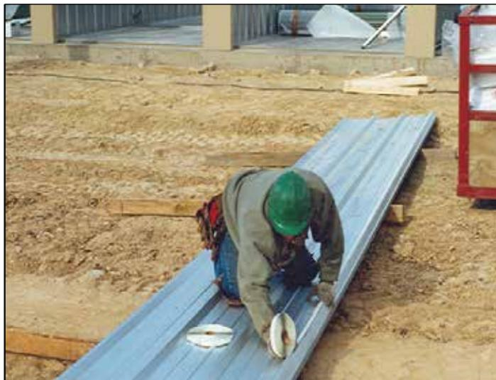
146. La masilla en cinta debe girarse hacia abajo 3" desde el borde de la lámina del techo, tal como se muestra en el tramo que tiene la correa. Si el edificio tiene una canaleta, gírela hacia abajo a 1" del borde.
