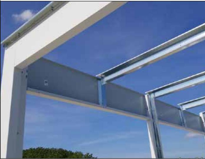
76. La correa instalada y con muescas está encima del dintel. Termine de apretar los pernos en las columnas bajas.
